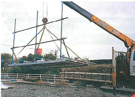
ユニット化工法
